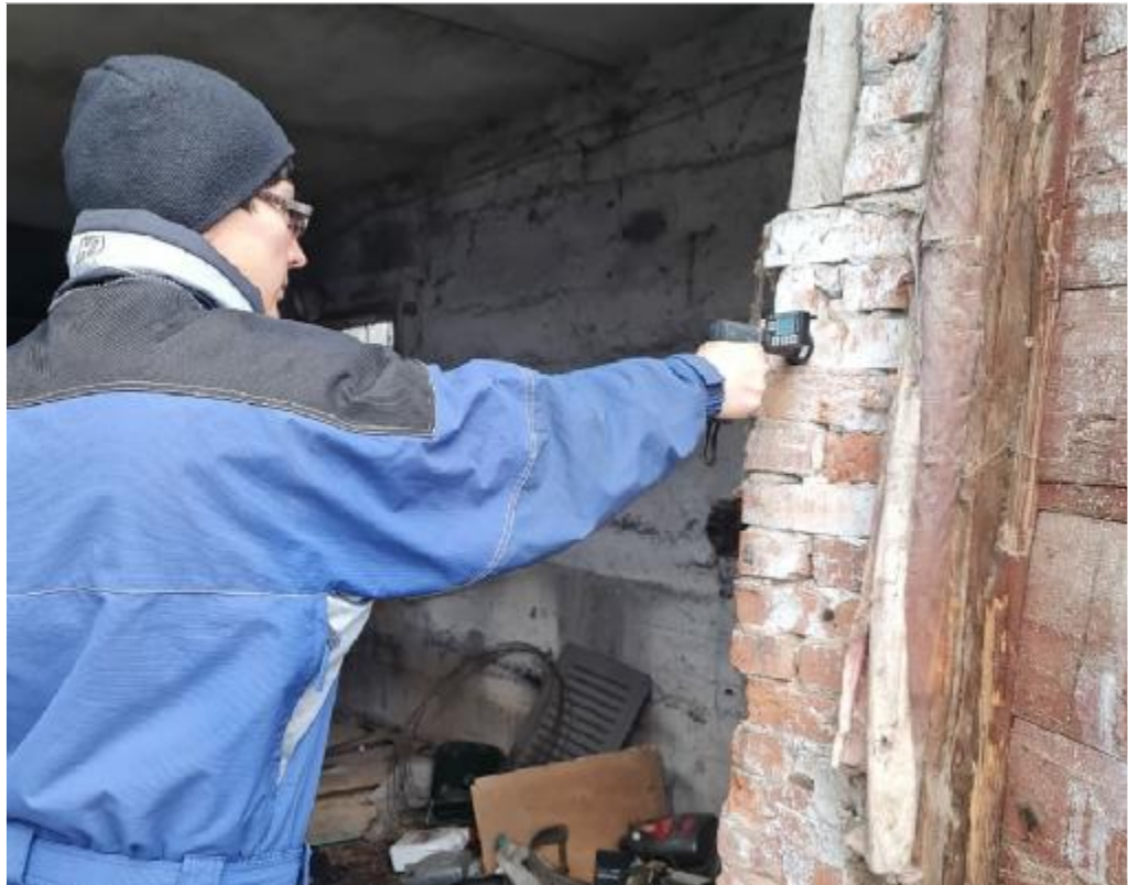
Определение прочности кирпича внутренних стен (№1)
