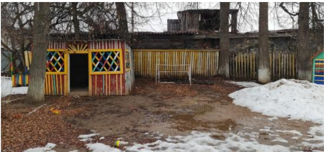
Рис. 6.2 Общий вид с задней стороны здания.
