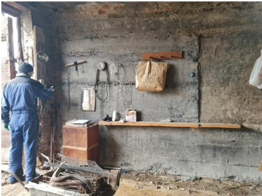
Замеры внутренних размеров здания
