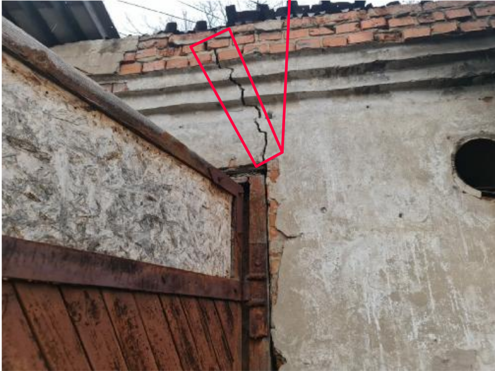
Рис.7.3 Наружные стены (вид спереди)
