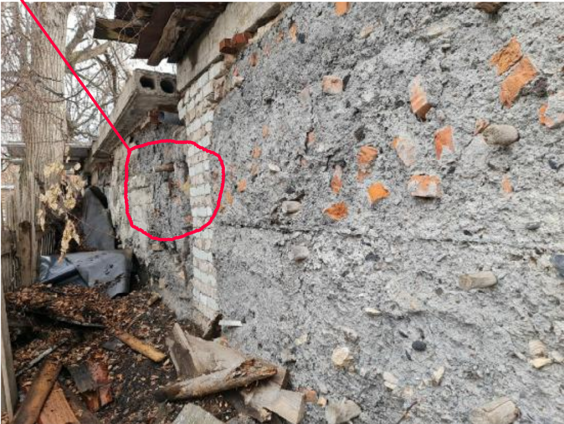
Рис.7.2 Наружные стены (Вид сзади)
