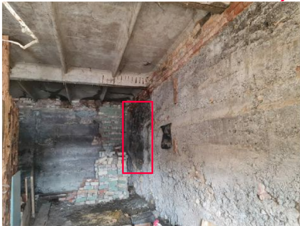
Рис.7.4 Внутренняя несущая продольная стена.
