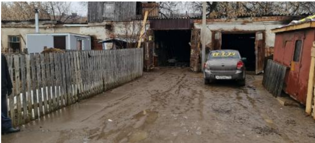
Рис. 6.1 Общий вид здания с фасадной стороны.
