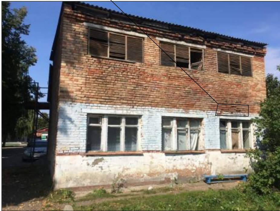
Рис.7.3 Фасадная сторона здания.
