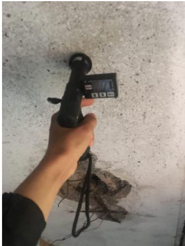
Рис. 16.2 Замеры прочности плиты перекрытия.
