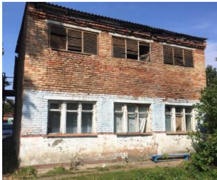
Рис. 6.1 Общий вид здания с фасадной стороны
