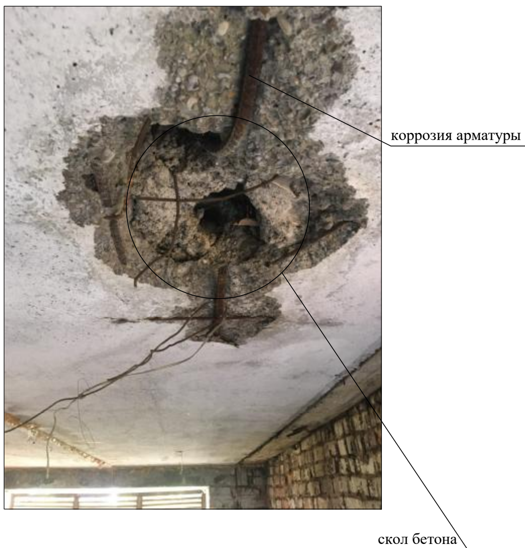
Рис.7.5 Покрытие. (плиты перекрытия многопустотные)
