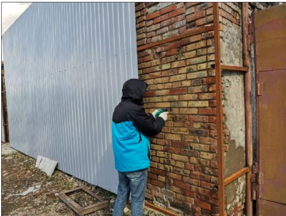
Определение прочности кирпича наружных стен (№5)
