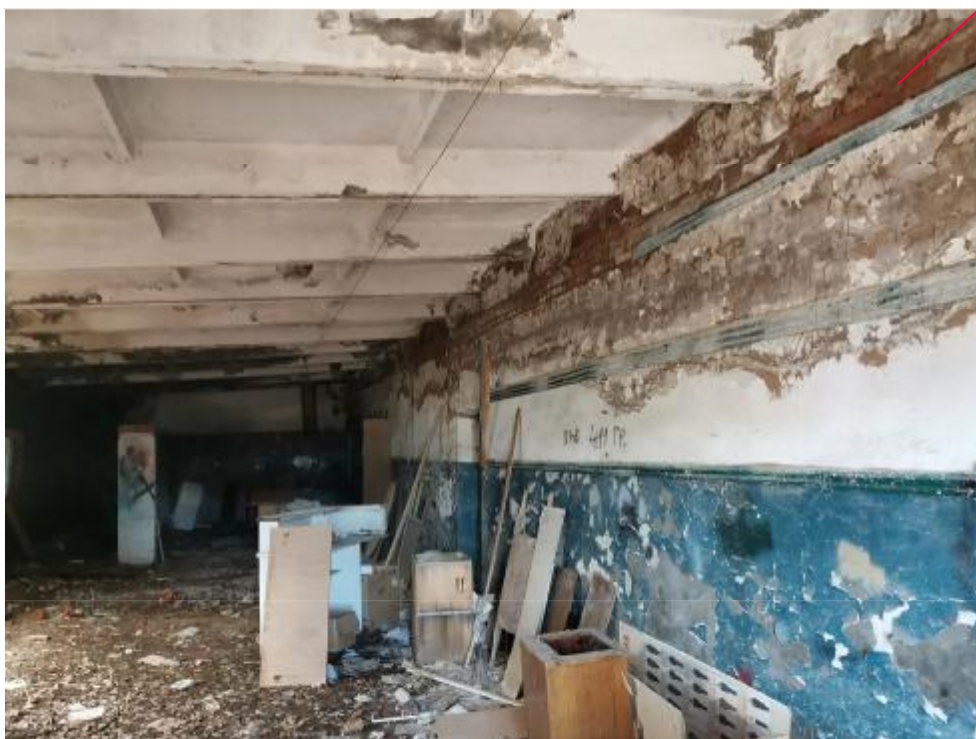
Рис.7.4 Внутренняя несущая продольная стена.
