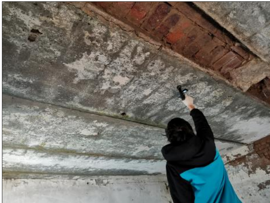
Определение прочности плит покрытия
