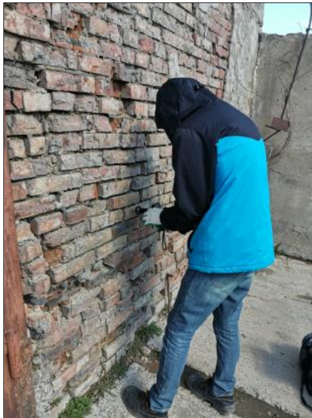
Определение прочности кирпича наружных стен (№4)
