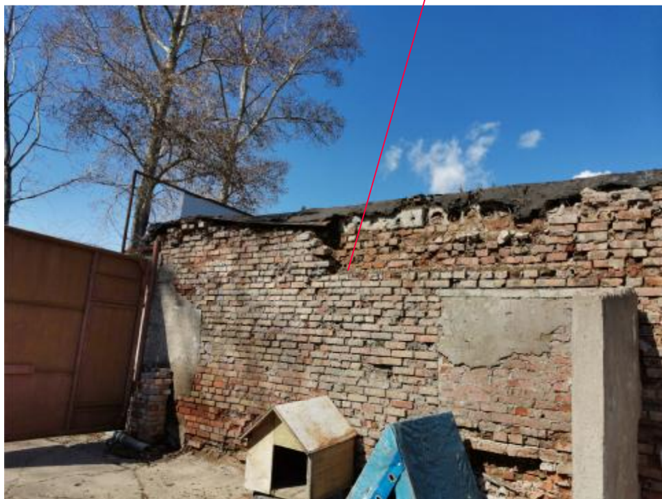
Рис.7.3 Наружные стены (вид снаружи)
