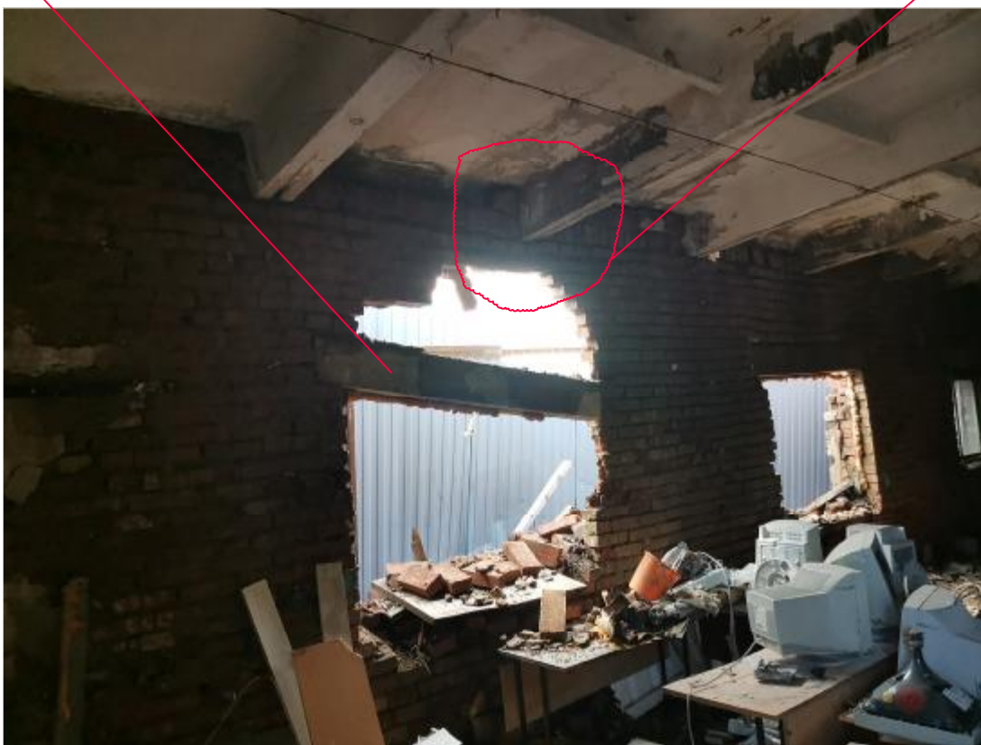
Рис.7.2 Наружные стены (Вид изнутри)
