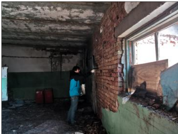
Определение прочности кирпича внутренних стен (№3)
